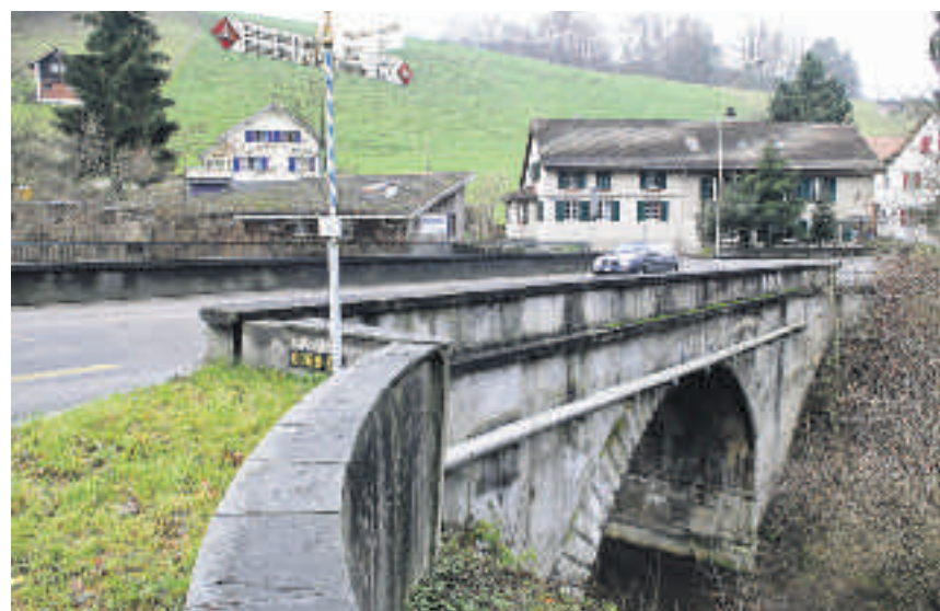
Die Aubrücke soll für Lastwagen von bis zu 480 Tonnen ausgebaut werden. Bild: mad
